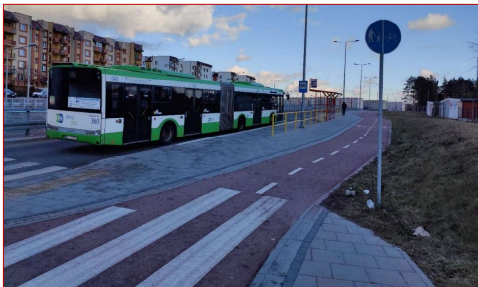
Rysunek 7.5 Przykład nowoczesnej i dobrze utrzymanej infrastruktury pieszej i rowerowej w okolicy przystanku PTZ
