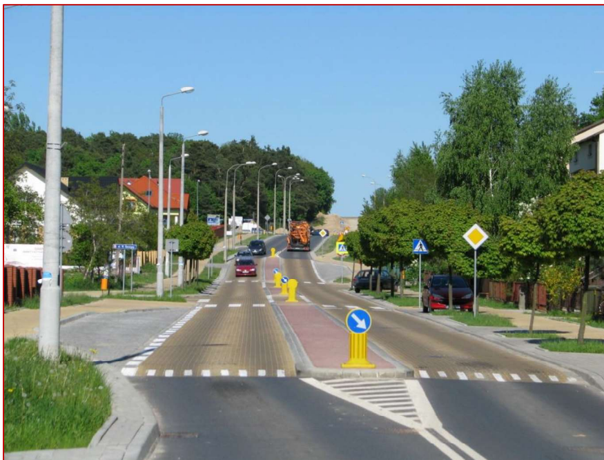
Rysunek 7.19. Ciąg drogi wojewódzkiej z elementami uspokojenia ruchu
